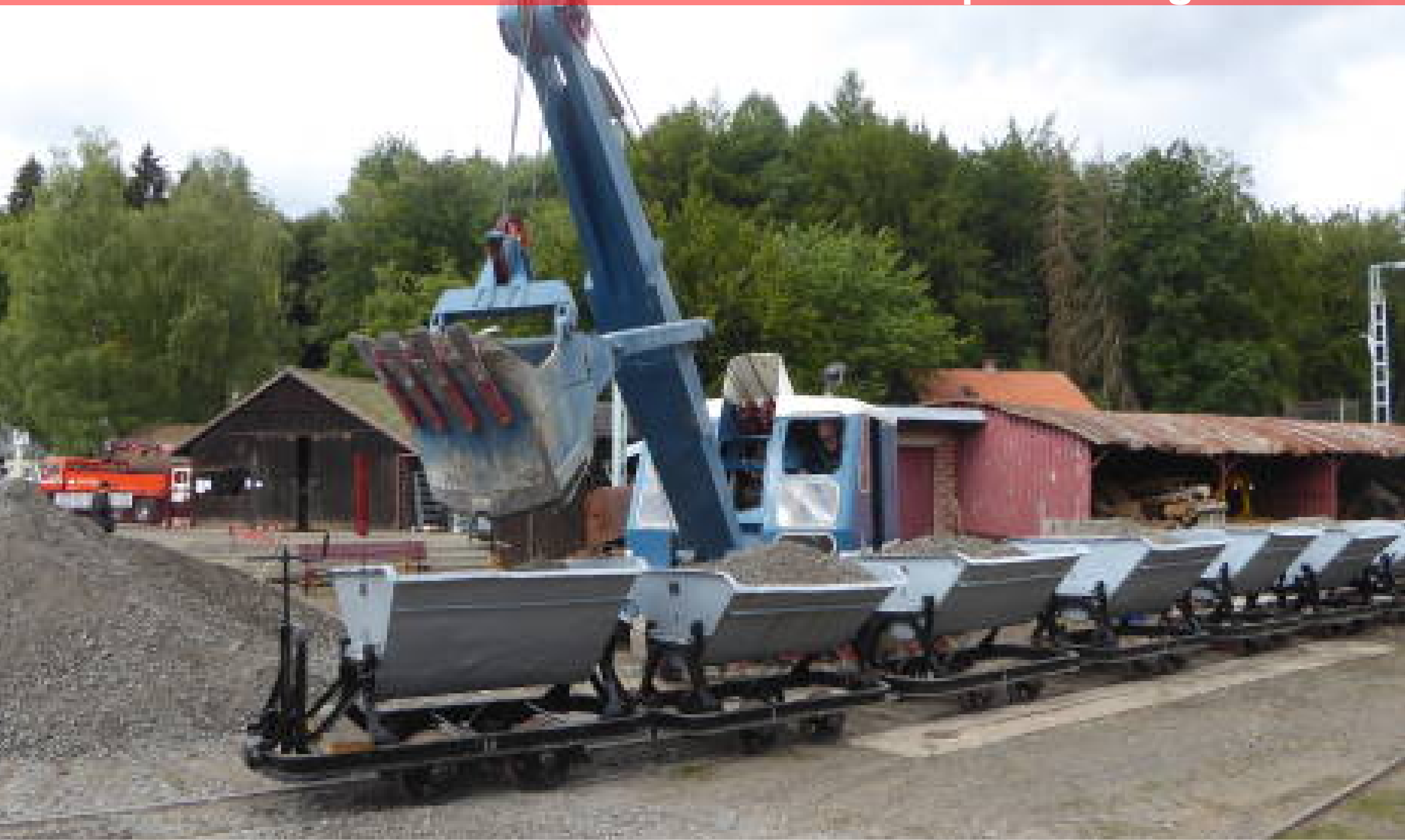
Dolberg D300 - Historische Baustelle 2018 Grube Fortuna
