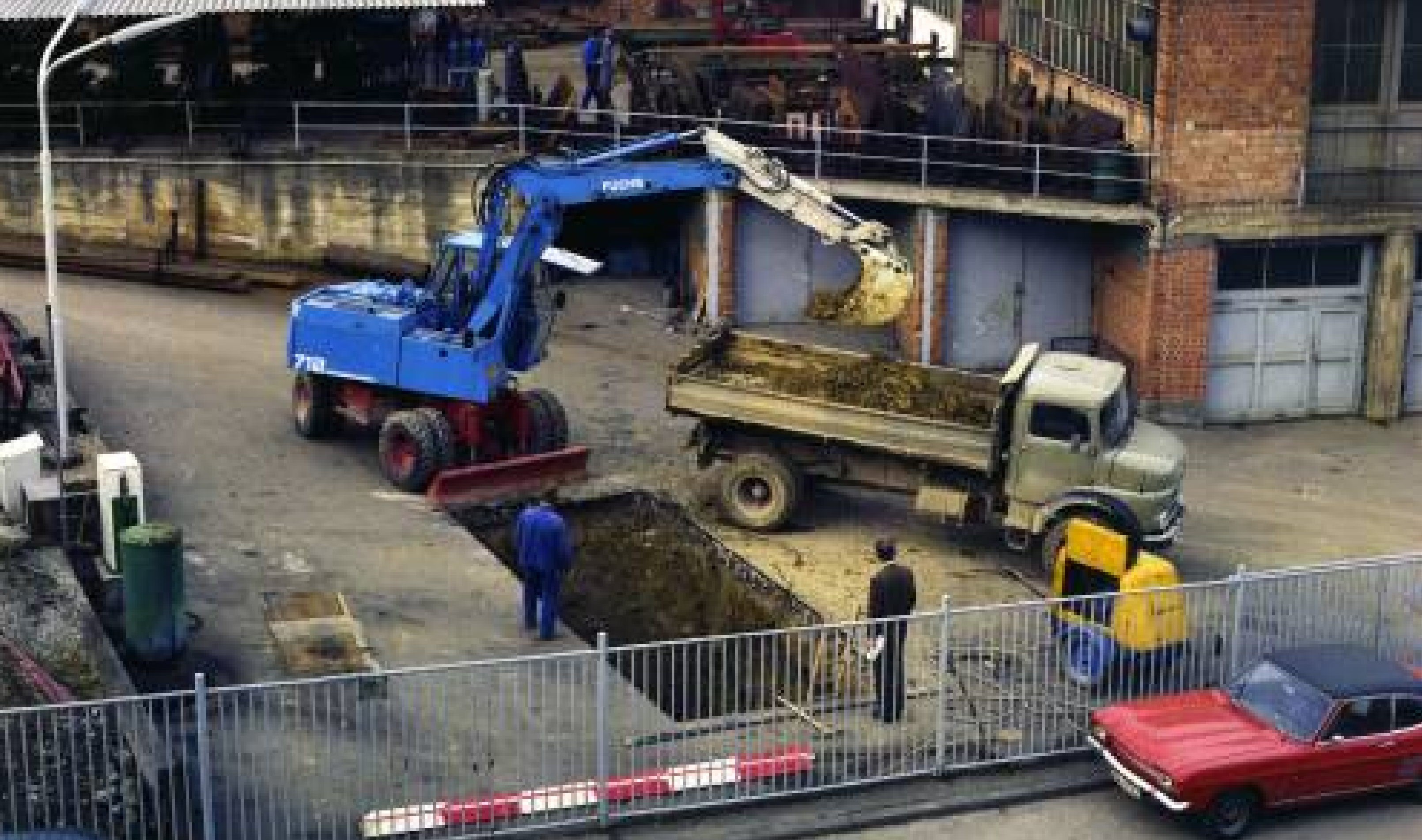
Fuchs 712 im Fuchs-Werk Ditzingen
